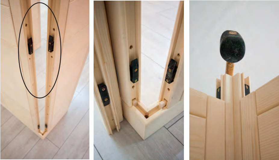
Abb. 4: Wandelemente mit Ecksteher verbinden
