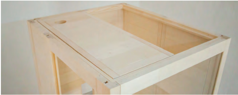
Abb. 14: Einlegen Dachelemente vorne
