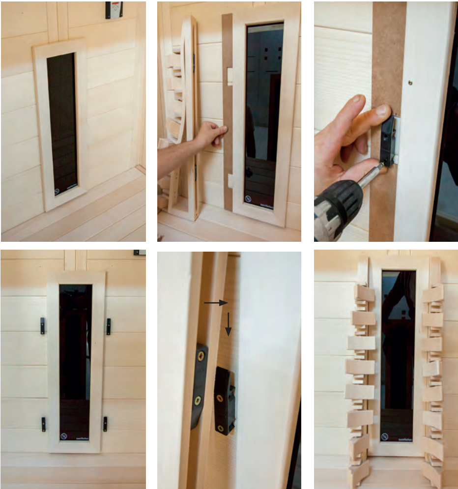
Abb. 29: Montage Rückenlehnen
