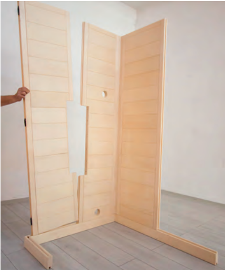
Abb. 6: Wandelement mit Ausschnitt einsetzen
