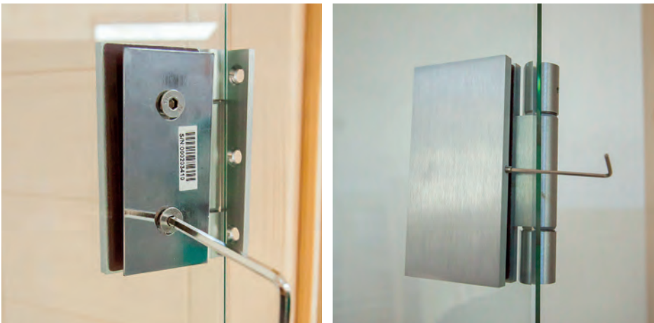
Abb. 32: Montage Türbeschläge 2
