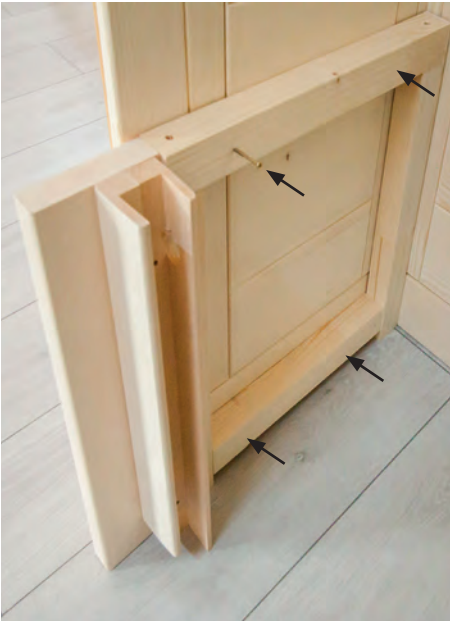
Abb. 18: Bankauflagen montieren
