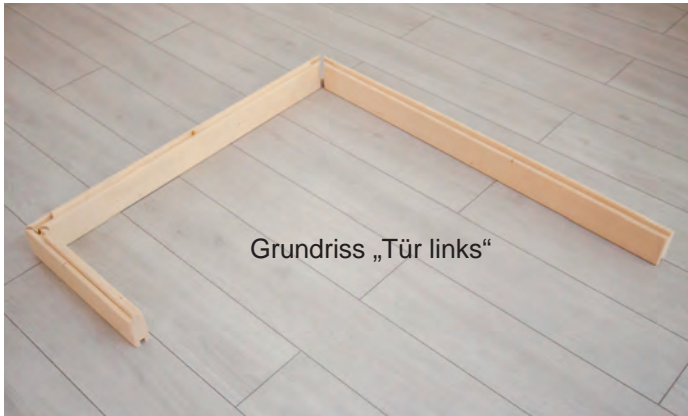
Abb. 1: Auflegen der drei Bodenrahmen-Elemente
