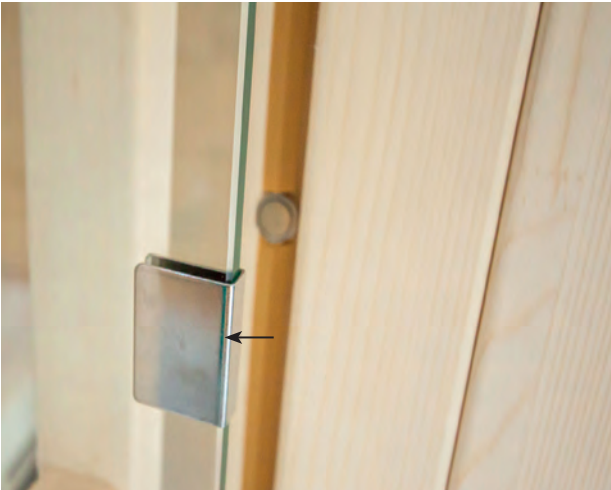
Abb. 35: Montage Überschub-Blech
